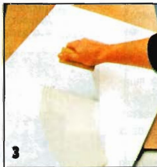
...используют универсальный клей, который наносят зубчатым шпателем на тыльную сторону плиты.
