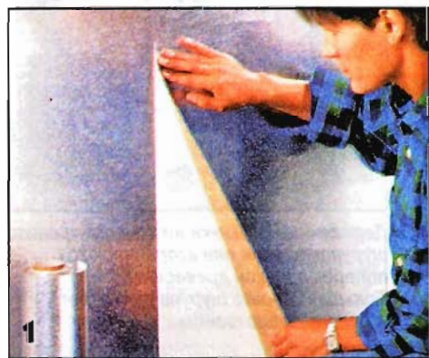
При необходимости шпательюют заднюю стенку ниши и наклеивают на нее фольгированную бумагу.
